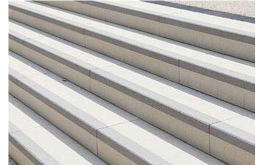
Treppenstufen mit Kontraststreifen
